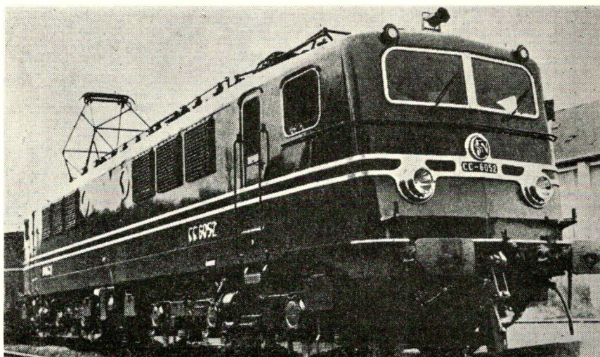
Et af de franske Nationalbaners forsøgslokomotiver til 50 p/s banen i Alperne. Det er udrustet med enfasebanemotoren for 50 p/s.
